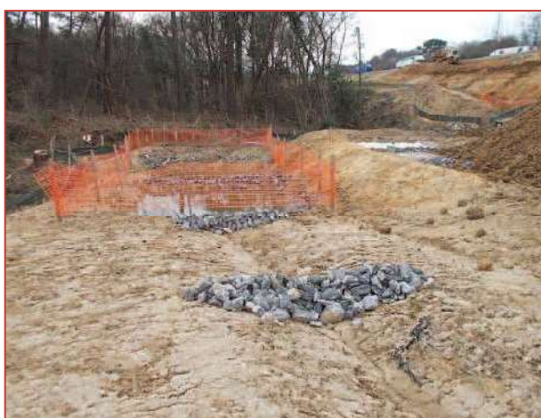
↑ Noue équipée de seuils en granulats concassés
